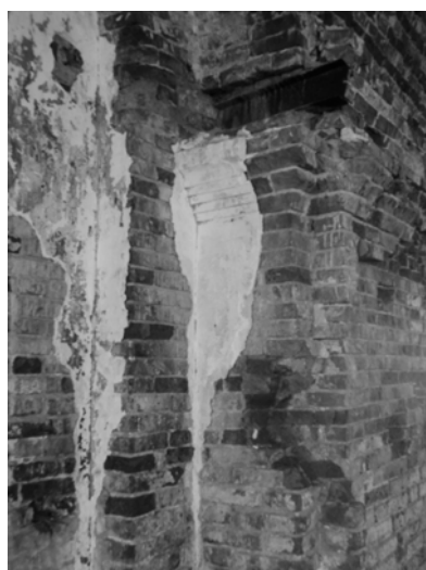
Рис. 4. Элементы штукатурки на стенах
